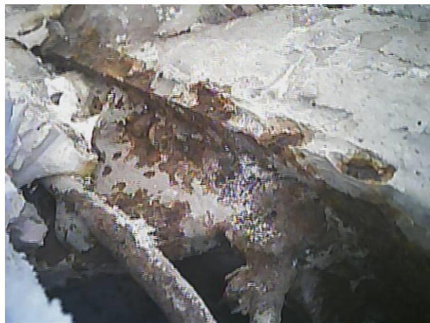
Particolare zanche metalliche per ancoraggio capitello in cls
