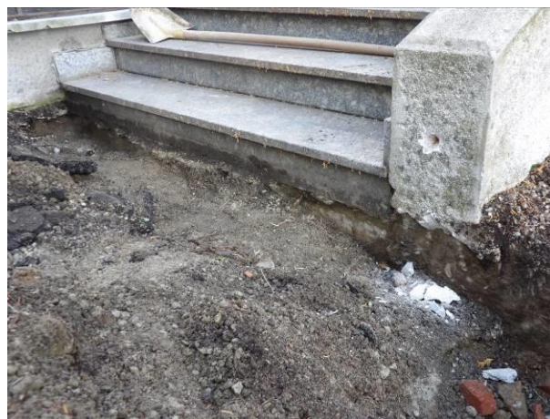
Vista dado di fondazione non ammorsato con muro Galleria J
