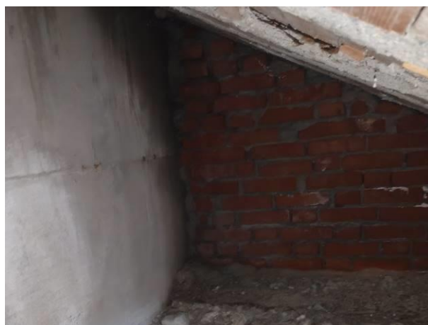
Vista parapetto scala in mattoni pieni in laterizio
