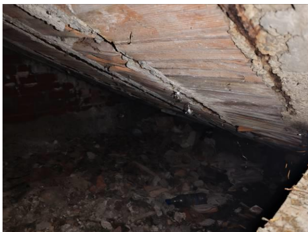
Vista appoggio rampa scala su muratura esistente in cls
