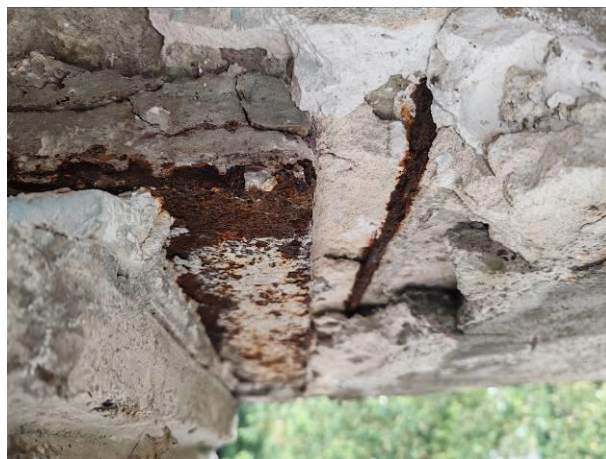
Vista piastra e fazzoletti metallici ancorata a pilastro
