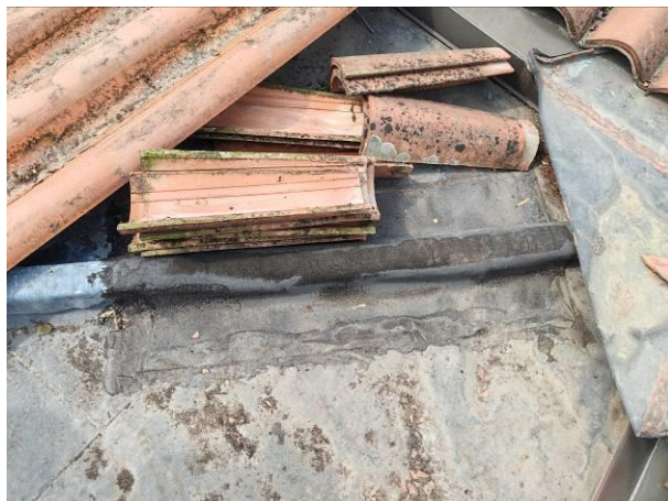
Vista ripristino con guaina catramata
