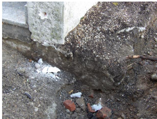
Vista dado di fondazione non ammorsato con muro Galleria J
