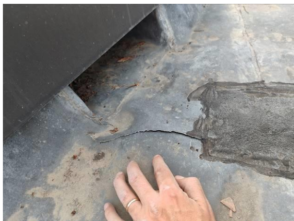
Vista stato fessurativo nella lattoneria in piombo
