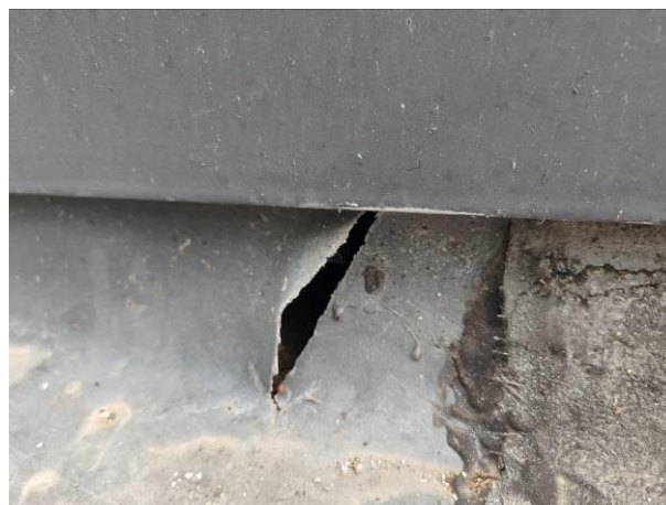
Vista stato fessurativo nella lattoneria in piombo
