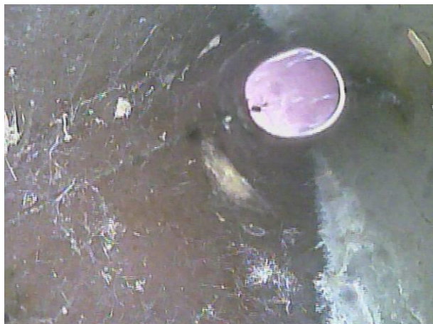
Vista innesto tra tubo di raccordo e pluviale verticale
