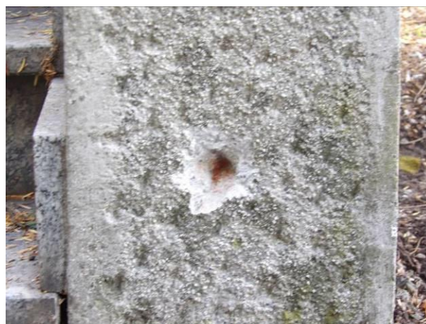
Vista parapetto scala in mattoni pieni in laterizio
