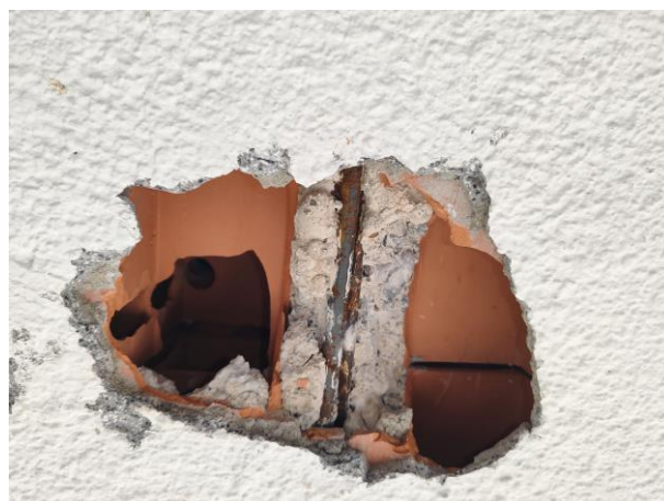
Vista travetto in c.a.
