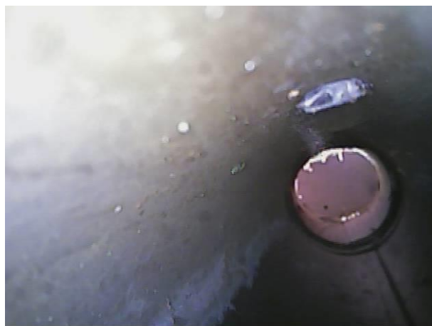
Particolare innesto tra tubo di raccordo e pluviale verticale
