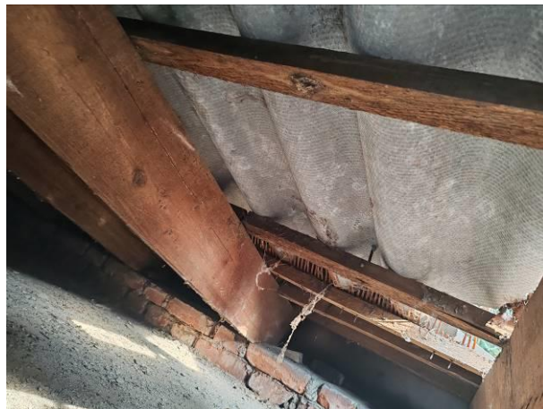
Vista orditura secondaria in listelli in legno e porta coppo in fibrocemento
