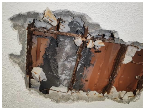
Vista barre trasversali e rete metallica tipo Nervometal
