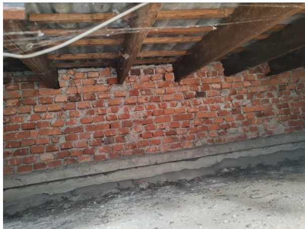
Vista radice in legno alla base della falda
