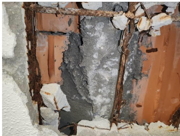
Particolare travetto ricostruito con malta strutturale, barre trasversali e rete metallica tipo Nervometal
