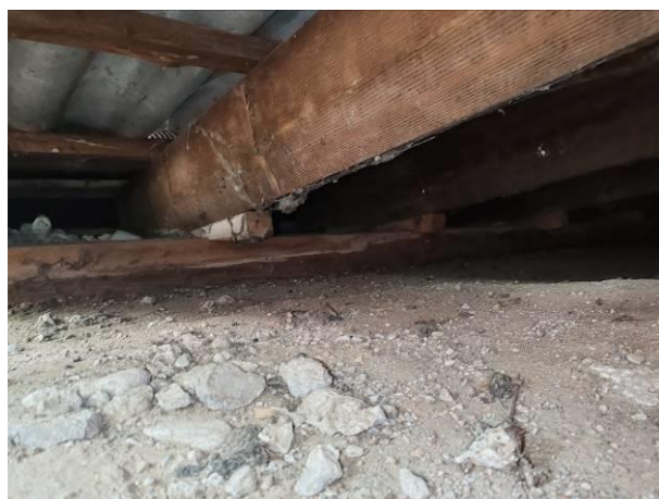
Vista orditura secondaria in listelli in legno e porta coppo in fibrocemento
