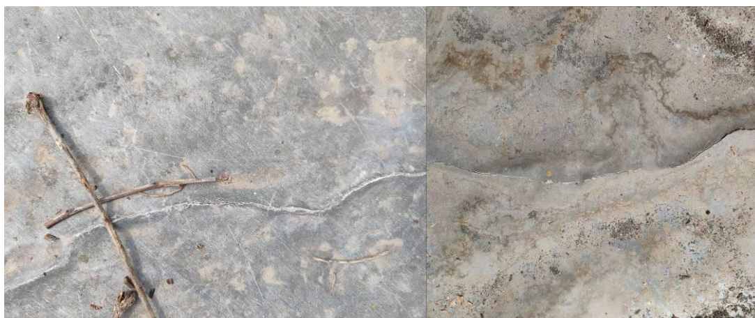
Vista stato fessurativo nella lattoneria in piombo
