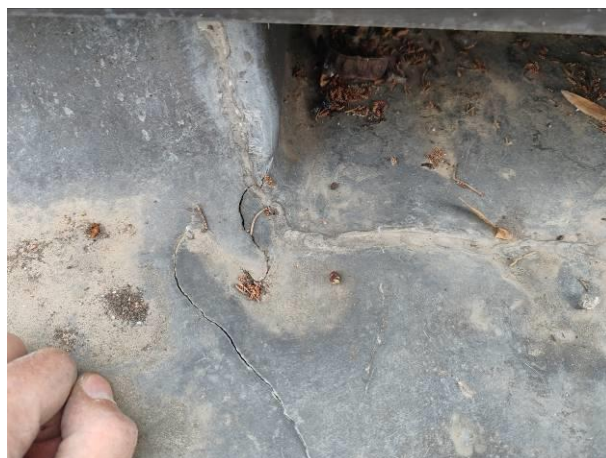
Vista stato fessurativo nella lattoneria in piombo
