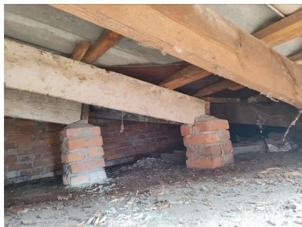
Vista pilastri in mattoni pieni per appoggio strutture in legno
