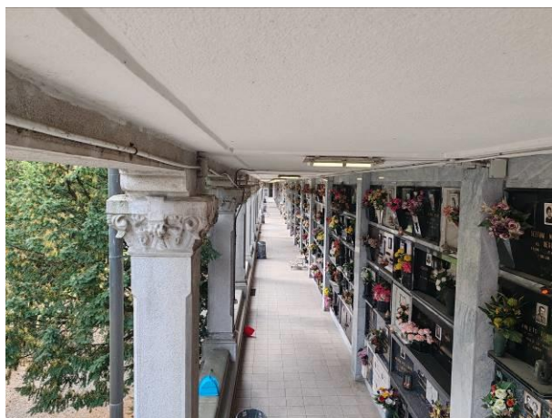
Vista trave in c.a. in appoggio su piastra metallica
