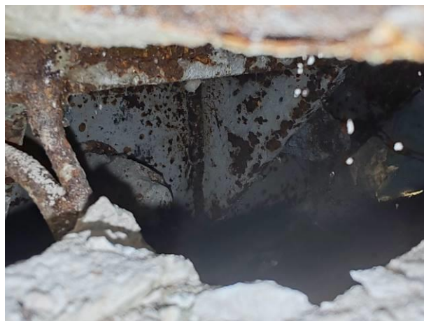
Vista piastra e fazzoletti metallici ancorata a pilastro
