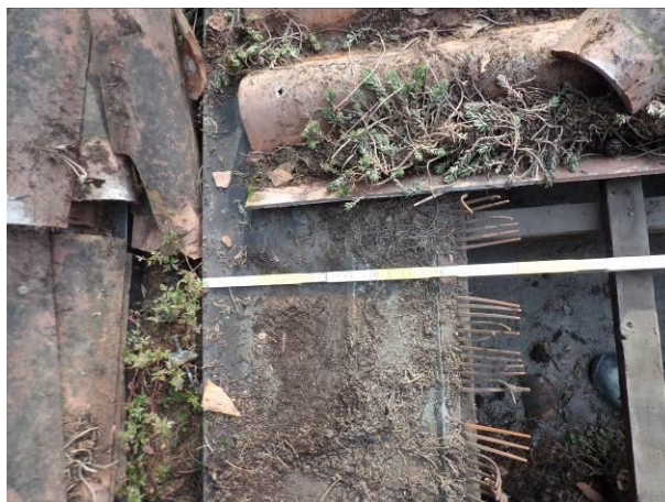
Vista canale di gronda in rame e pettine parapassero in PVC
