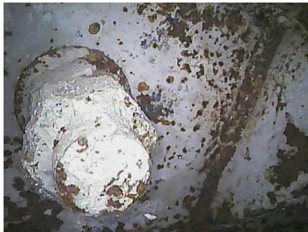
Particolare zanche metalliche per ancoraggio capitello in cls
