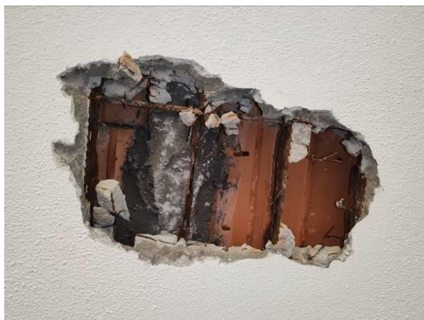
Particolare travetto ricostruito con malta strutturale, barre trasversali e rete metallica tipo Nervometal
