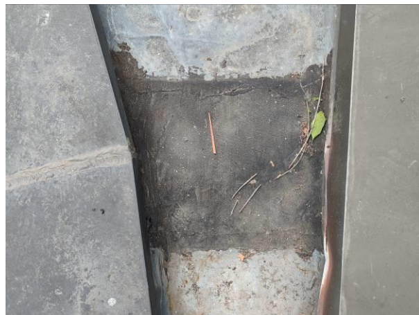
Vista ripristino con guaina catramata
