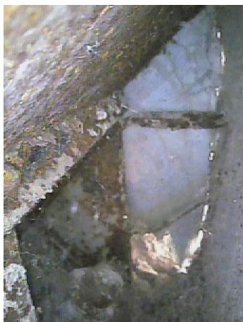
Vista zanche metalliche per ancoraggio capitello in cls
