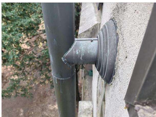
Vista innesto tra tubo di raccordo e pluviale verticale
