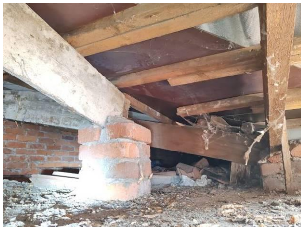
Vista intradosso compluvio in rame
