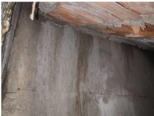
Vista appoggio rampa scala su muratura esistente in cls
