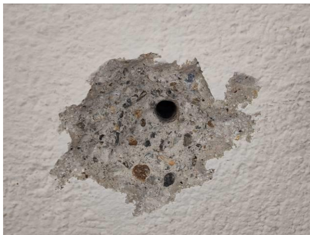
Vista d'insieme assaggio localizzato
