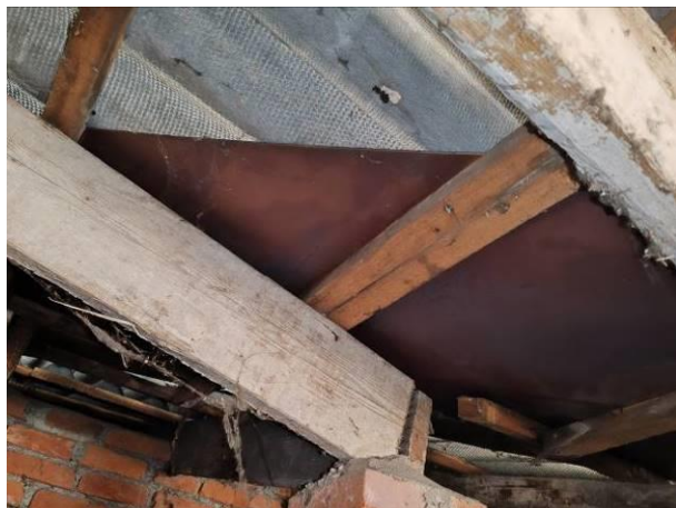
Vista intradosso compluvio in rame
