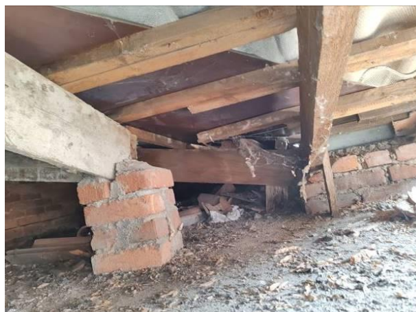
Vista pilastri in mattoni pieni per appoggio strutture in legno
