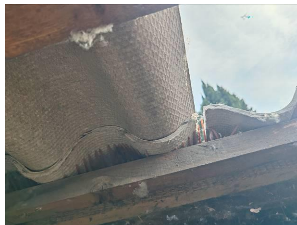
Vista lastra porta coppo in fibrocemento
