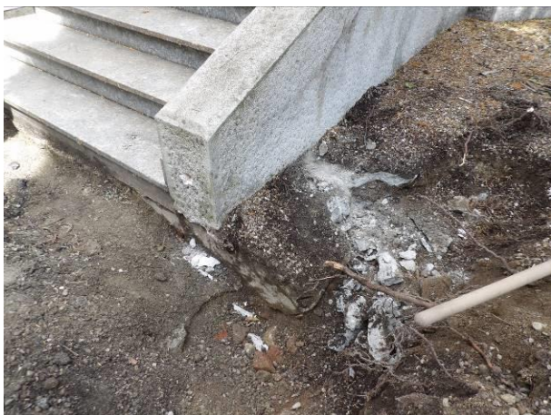
Vista dado di fondazione parapetto in muratura
