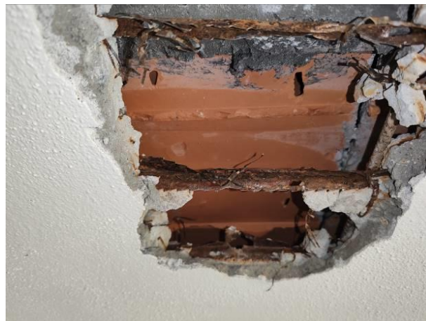
Vista barre trasversali e rete metallica tipo Nervometal
