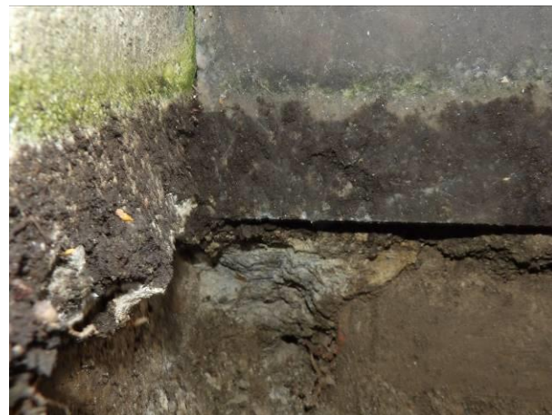
Vista dado di fondazione parapetto in muratura
