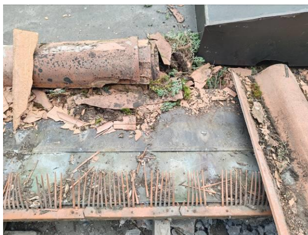
Vista canale di gronda in rame e pettine parapassero in PVC
